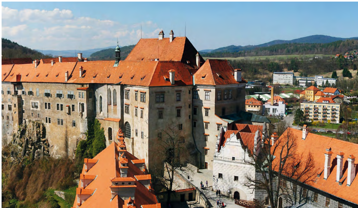
Zámek v Českém Krumlově, v jehož areálu probíhalo první výukové soustředění UA.
